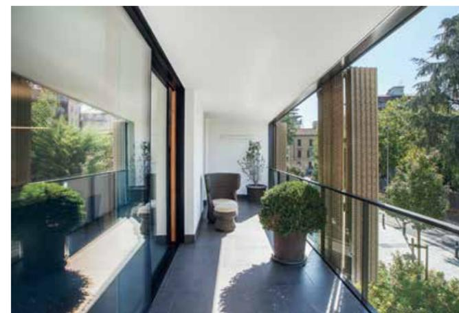
Il complesso residenziale Bergamo+ è stato progettato mettendo in primo piano le caratteristiche tecniche ed estetiche delle facciate. A tale scopo è stato adottato il serramento Vivaldi Integrale in Tecnorovere di Italserramenti: i suoi vetri a scalino incollati strutturalmente dalla parte esterna della finestra hanno consentito di ottenere una migliore statica e contemporaneamente di evitare costi di manutenzione
